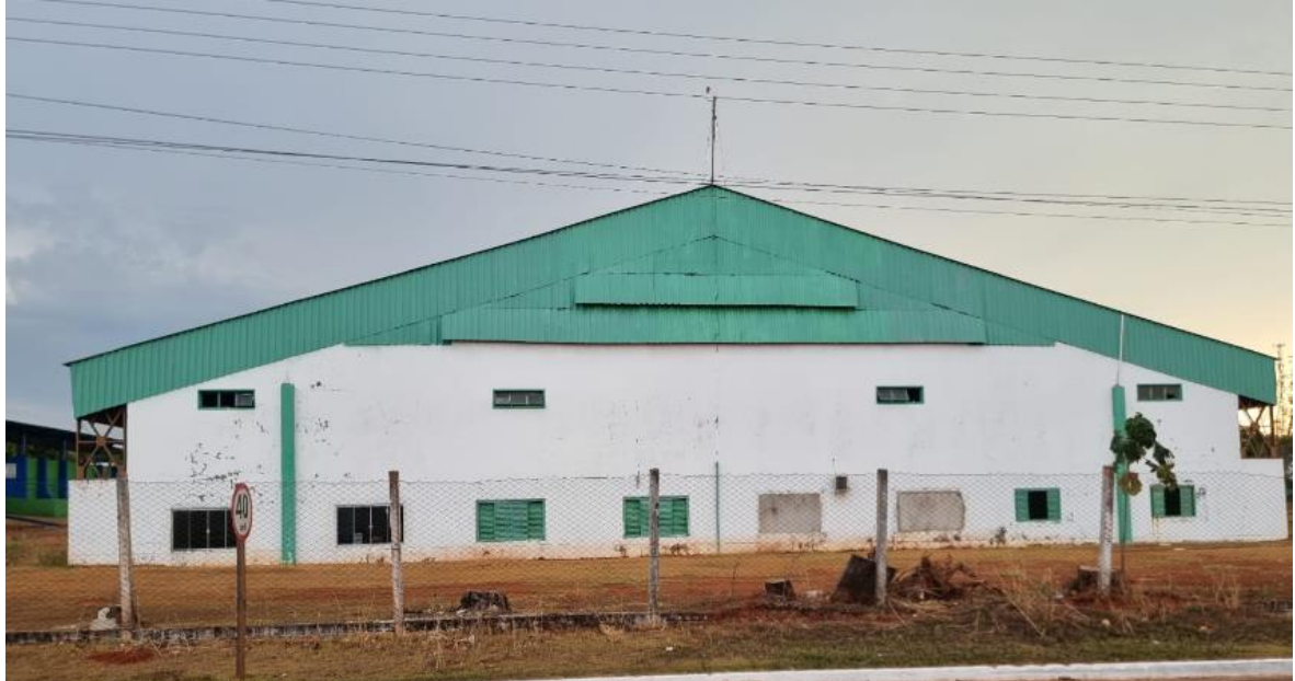
Figura 05 - Visão frontal de onde será instalado o sistema
